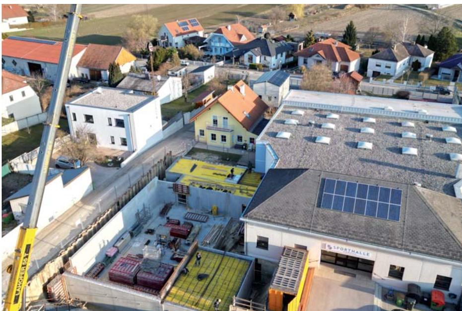
Seit Anfang des Jahres wird auch am neuen Turnsaal gearbeitet. Es erfolgten die Errichtung der Spundwände und der Aushub. Die notwendigen Pfähle für das Fundament wurden gerammt und die Bodenplatte betoniert. Aktuell werden die Wände des Erdgeschosses betoniert.
